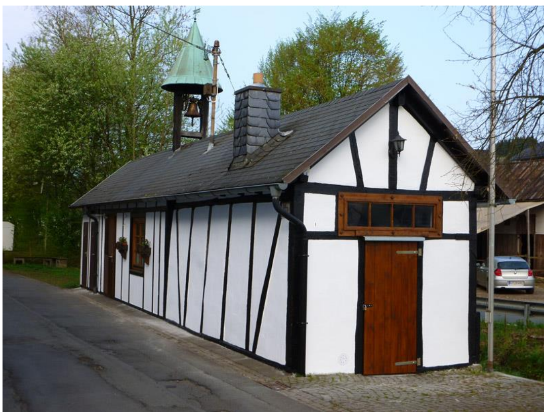
Der Ölgerschüler „Backes“ nach der Renovierung der Außenfassade 2015
